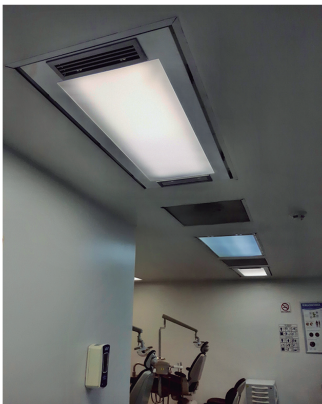
Figura 5: Colocación de lámparas de purificación de aire y disminución de bacterias.
