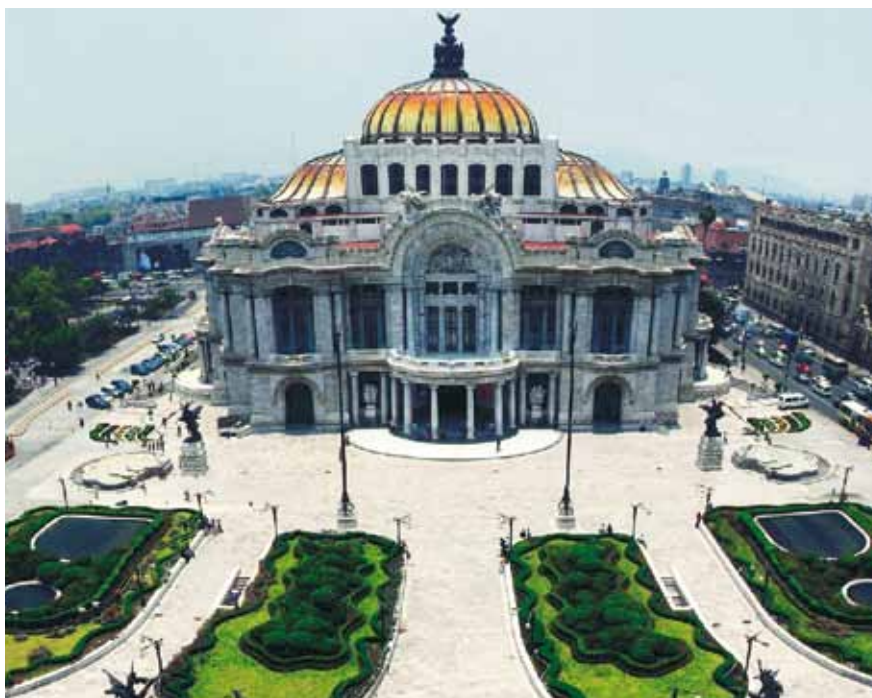
Conjunto del Palacio de Bellas Artes. Avenida Benito Juárez, México, D.F.
