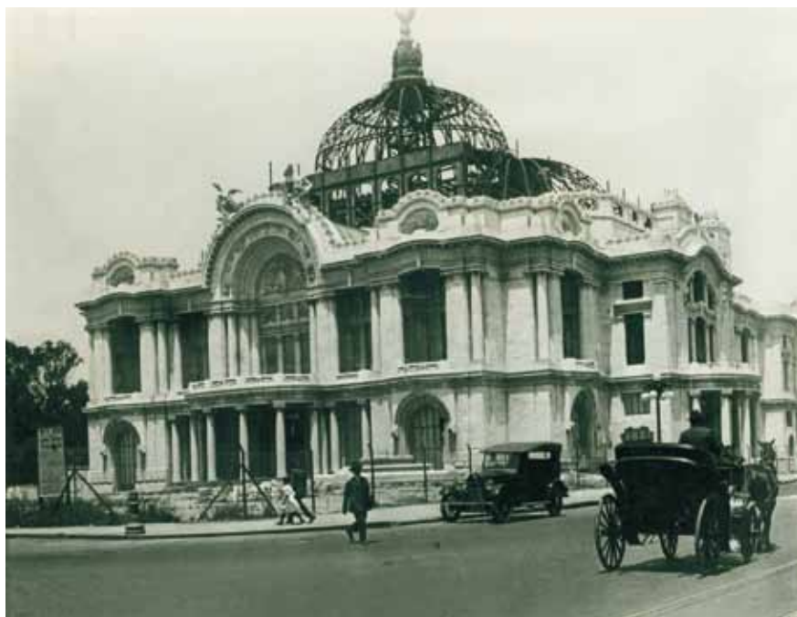
Foto de Bellas Artes de 1917 en construcción. Víctor Souvade. Archivo C. Cantú B.
