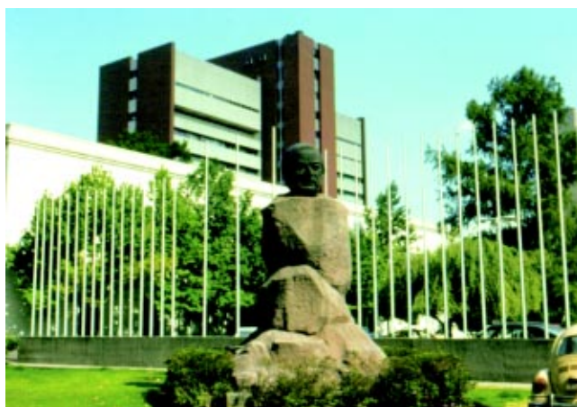
Figura 1. El Hospital Juárez, con vista a la Torre de Hospitalización que se colapsó durante el terremoto de 1985.
