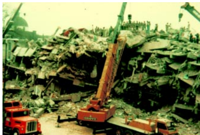
Figura 2. Torre de Hospitalización del Hospital Juárez, colapsada durante el terremoto de 1985. Al fondo se observa el auditorio principal ubicado en la antigua iglesia de San Pablo.
