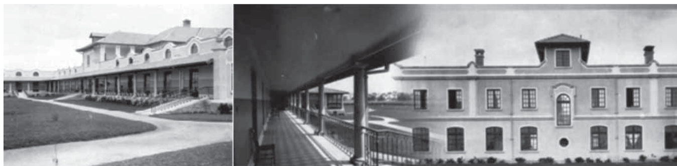
Figura 3. Sanatorio Cowdray, Hospital Inglés (izquierda), que posteriormente se convirtió en The American British Cowdray Hospital (derecha).
