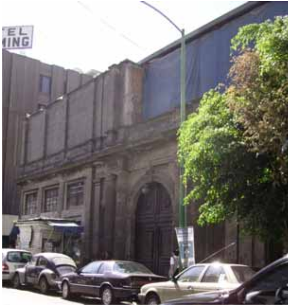
Figura 1. Lo que queda del edificio que albergó al Hospital de Maternidad e Infancia de 1866 hasta 1905. (Fotografía tomada por Rodrigo Nieto Fierro, junio 2007).
