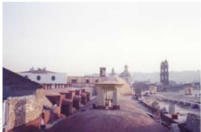
Figura 3. Hospital de San Pedro. Torrecilla de ventilación en la azotea.
