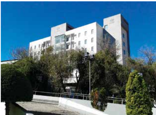
Figura 8: Hospital Regional «1º de Octubre» del ISSSTE.
