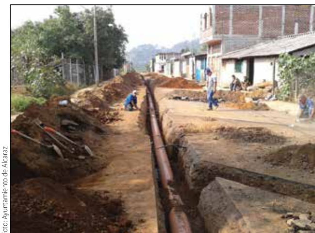
Figura 2. Construcción de drenaje.
