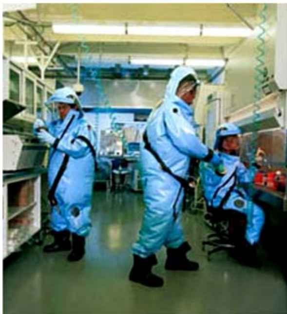
Figura 2. Ejemplo de equipo de protección personal e instalaciones requeridas en los laboratorios de bioseguridad nivel 4. El personal está completamente cubierto y aislado del exterior, además, está conectado a fuentes de aire limpio para evitar que respiren el que se encuentra en el laboratorio. Todo el trabajo de laboratorio se lleva a cabo en campanas de flujo laminar. 7
