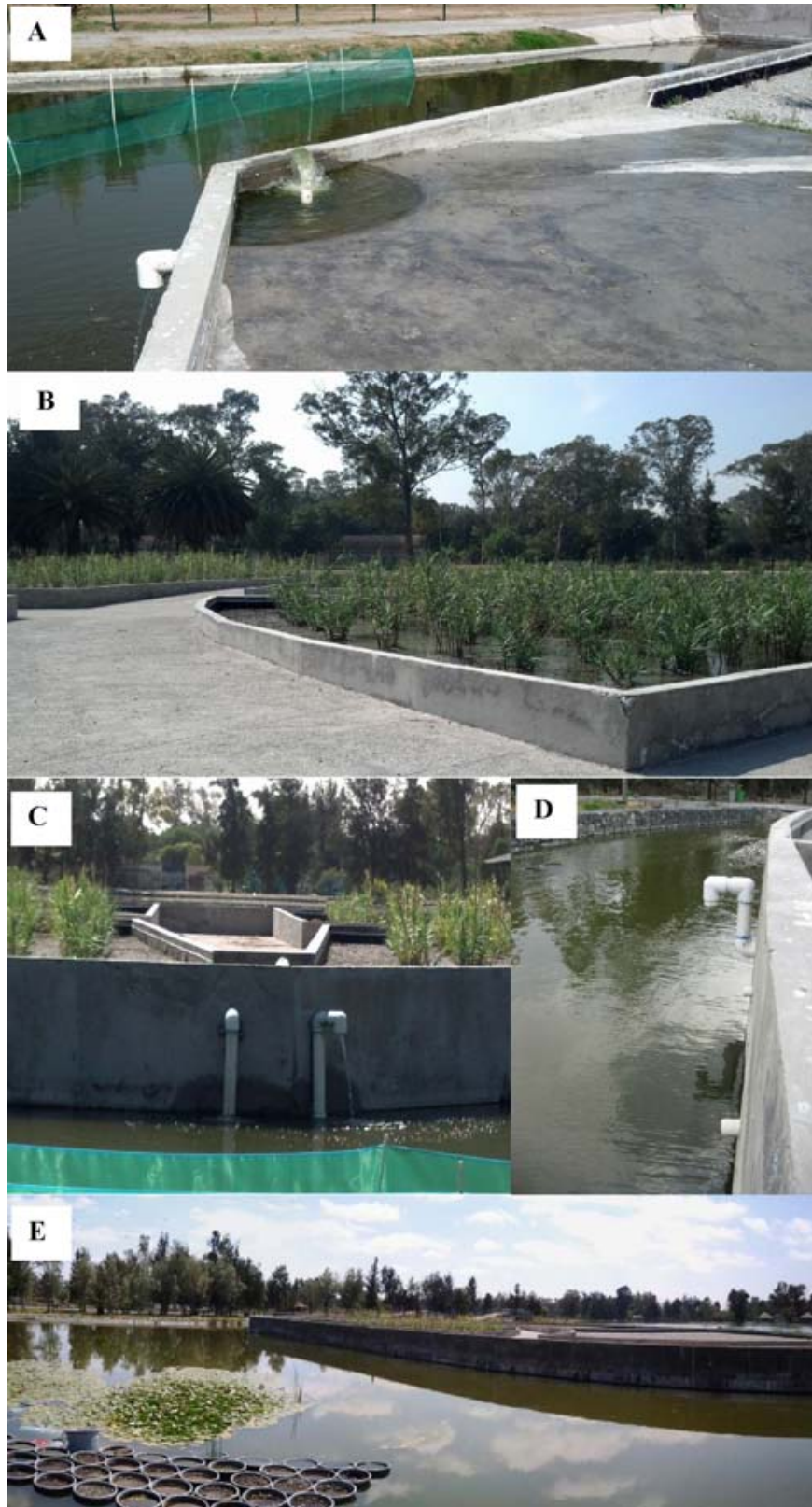
Figura 14. Imágenes por etapa del funcionamiento del STHA: A) Influyente del HAFSS. B) Celdas depuradoras del HAFSS. C y D) Efluente del HAFSS. E) HAFS.
