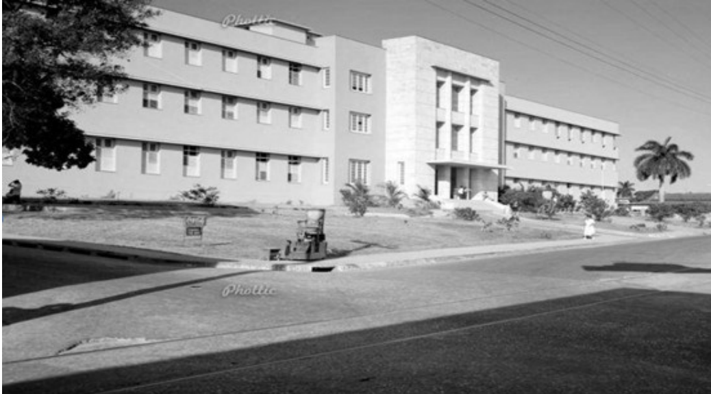
Fig. 2. Remodelación del hospital civil de Matanzas.
