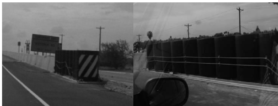
FIGURA 1. ATENUADORES DE IMPACTO DE ACERO USADOS EN EL ESTADO DE TEXAS, ESTADOS UNIDOS
