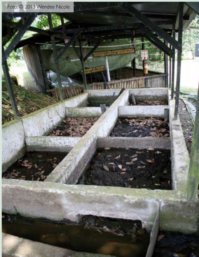
Seis biodigestores en el campus de la Universidad EARTH convierten los desechos animales y humanos en fertilizante y biogas. En los últimos años, la EARTH también ha instalado más de 2 000 biodigestores en granjas y empresas en toda Costa Rica.
