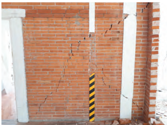
FIGURA 15. MUROS DE CARGA CON FALLA POR CORTANTE
