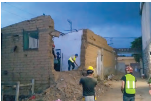
a) Vivienda en Ocuilco, Morelos
