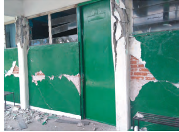
FIGURA 19. DAÑOS EN ESCUELAS EN MORELOS (EFECTOS DE COLUMNA CORTA)
