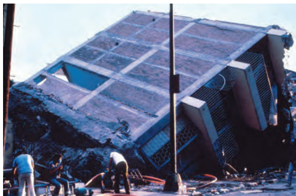
a) Edificio colapsado en la colonia Roma
