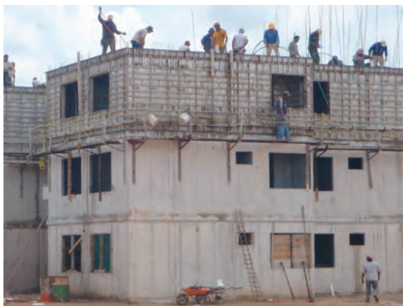
a) Construcción de departamentos
