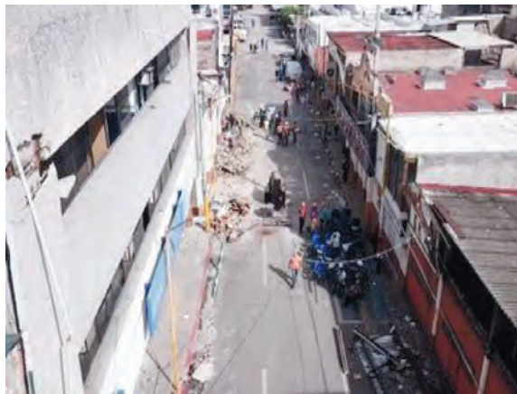
b) Daños observados en una calle en Jojutla
