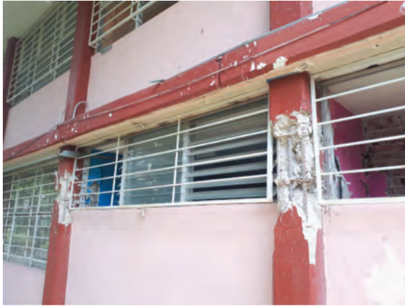
FIGURA 19. DAÑOS EN ESCUELAS EN MORELOS (EFECTOS DE COLUMNA CORTA)
