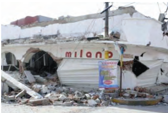
a) Estructura en esquina
