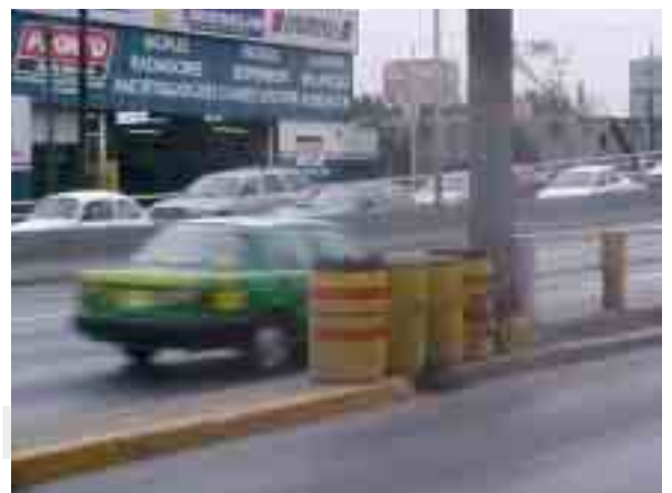
Figura 1. Algunas medidas protectoras de bajo costo incluyen la colocación de barriles sellados llenos de agua que absorban el impacto en caso de estrellamiento.
